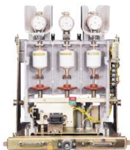
Одностабильный приводной механизм
